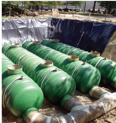
Fot. 2. Zbiornik retencyjny wykonany na bazie prefabrykowanych zbiorników Flowtite
