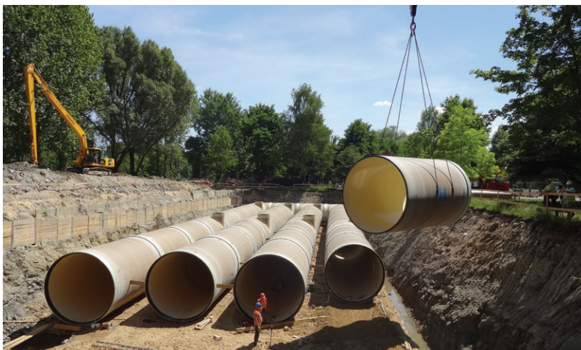
Fot. 1. Zbiorniki retencyjne w układzie szeregowym montowane na bazie rur Hobas
