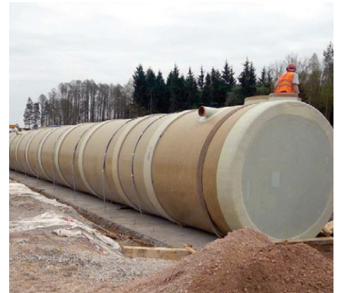
Fot. 3. Budowa liniowego zbiornika retencyjnego – Trasa S8
