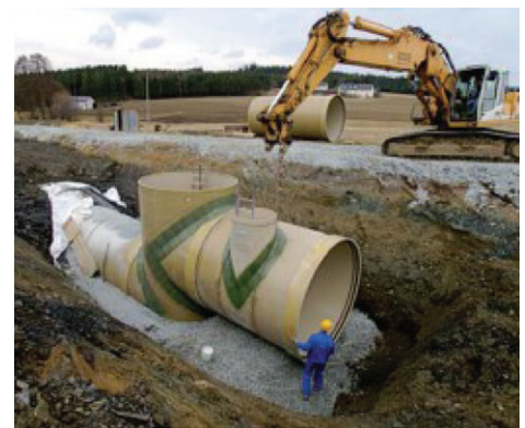
Fot. 4. Montaż zbiornika retencyjno-odciążającego z rur Flowtite na kanalizacji ogólnospławnej
