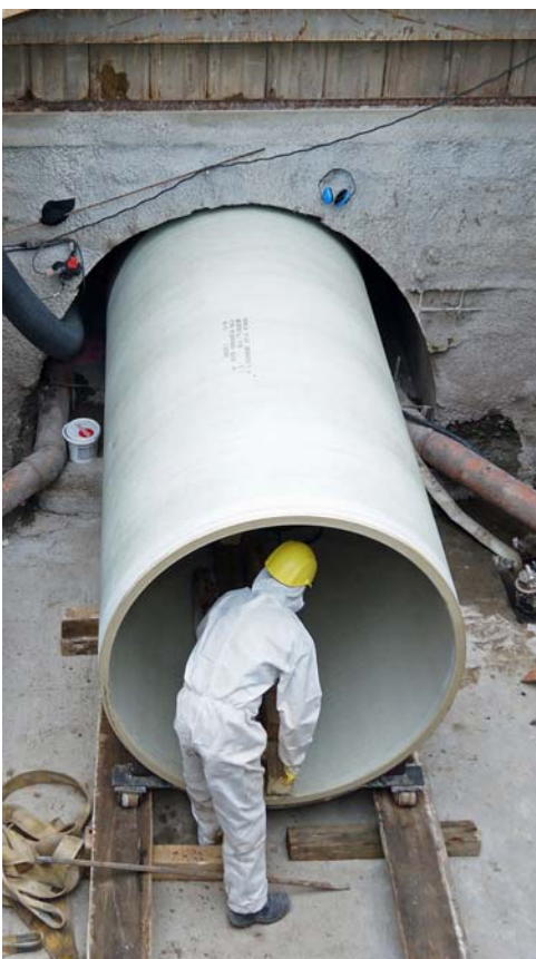
Bild 2: Querung einer Bahntrasse mit Fowtite GFK - Rohren
